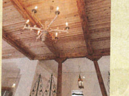
リビングの天井は、すべて無垢の木。メインの照明と間接照明をつけることでロマンチックな雰囲気になって、プライベートルームからの眺めもお気に入り。
